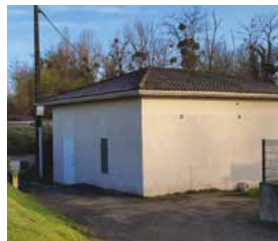
NRO : Nœud de Raccordement Optique.
