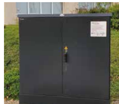
SRO : Sous Répartition Optique.
