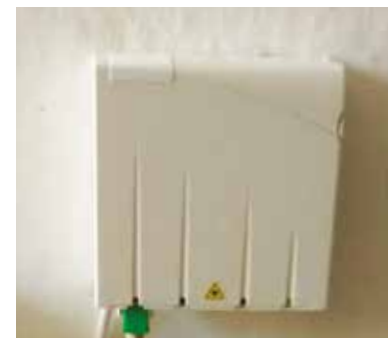
PTO : Point de Terminaison Optique.
