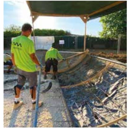
Construit en deux mois et demi, le skatepark de Montussan est un modèle du genre. Le béton a été entièrement moulé sur des modules préformés. Le revêtement est plus silencieux qu'un enrobé classique, plus résistant dans le temps et plus facile d'entretien. D'une surface de 600 m<sup>2</sup>, il peut accueillir des compétitions.
