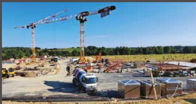
En quelques semaines, le site du futur collège de Montussan a changé. Après les travaux de terrassement, ceux de construction avancent à bon rythme. 300 pieux d'une dizaine de mètres de profondeur ont été posés pour stabiliser les infrastructures. Le chantier s'attaque à la géothermie avec des forages de 180 mètres. Déjà, les fondations du gymnase et du bâtiment éducatif se dessinent.
